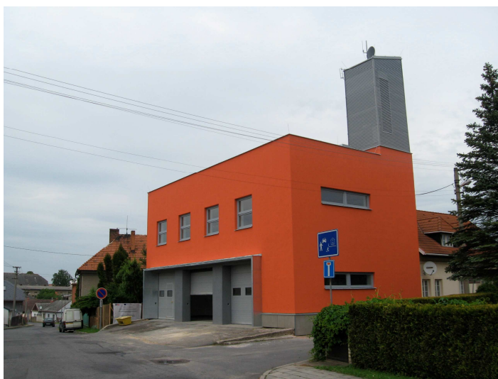
Hasičská zbrojnice v Holasovicích po opravě
